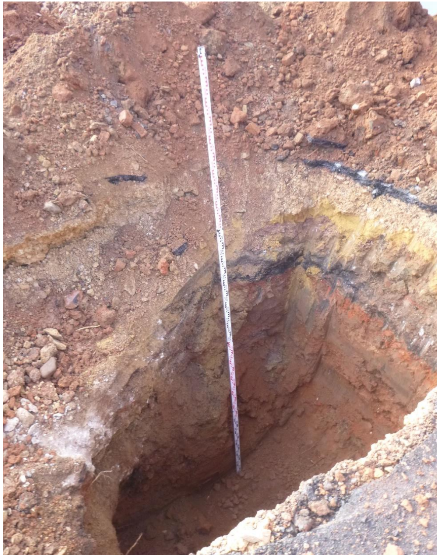
Abbildung 3: Blick in den Baggerschurf Sch2 am 22.01.2021
