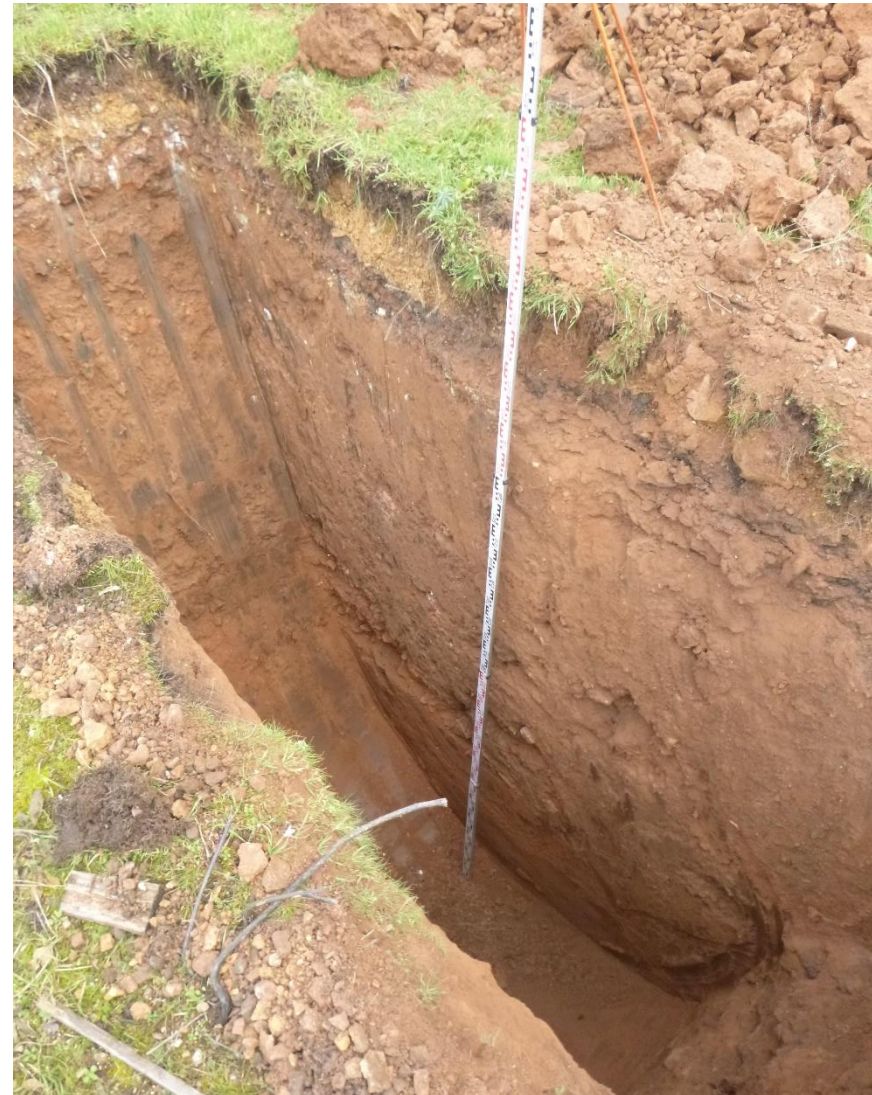
Abbildung 2: Blick in den Baggerschurf Sch3 am 22.01.2021
