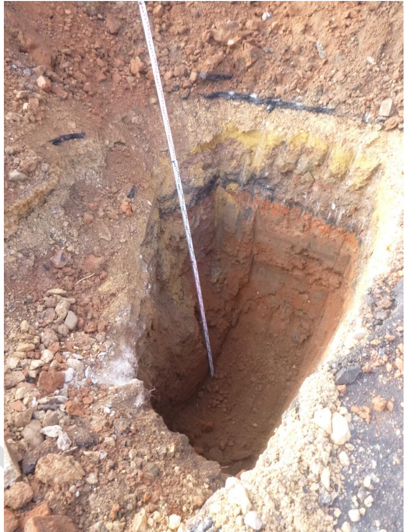
Abbildung 3: Blick in den Baggerschurf Sch2
