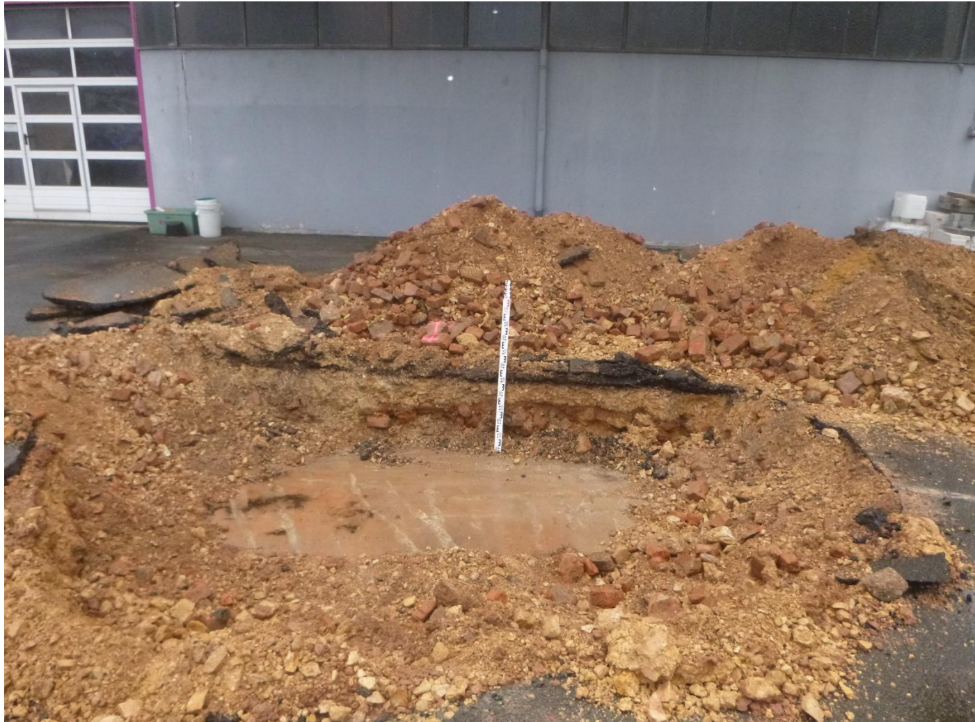
Abbildung 1: Blick in den Baggerschurf Sch1 am 22.01.2021
